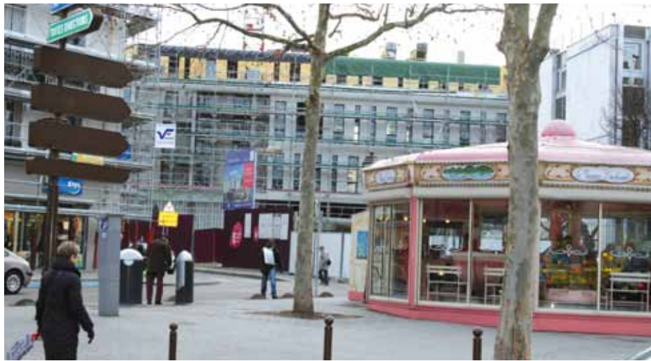
Le futur Monoprix et son parking souterrain (au centre) devraient ouvrir fin mai. L'ensemble comprendra également 46 logements
